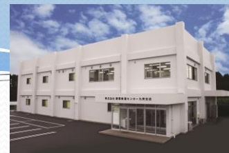
九州支店・検査所
